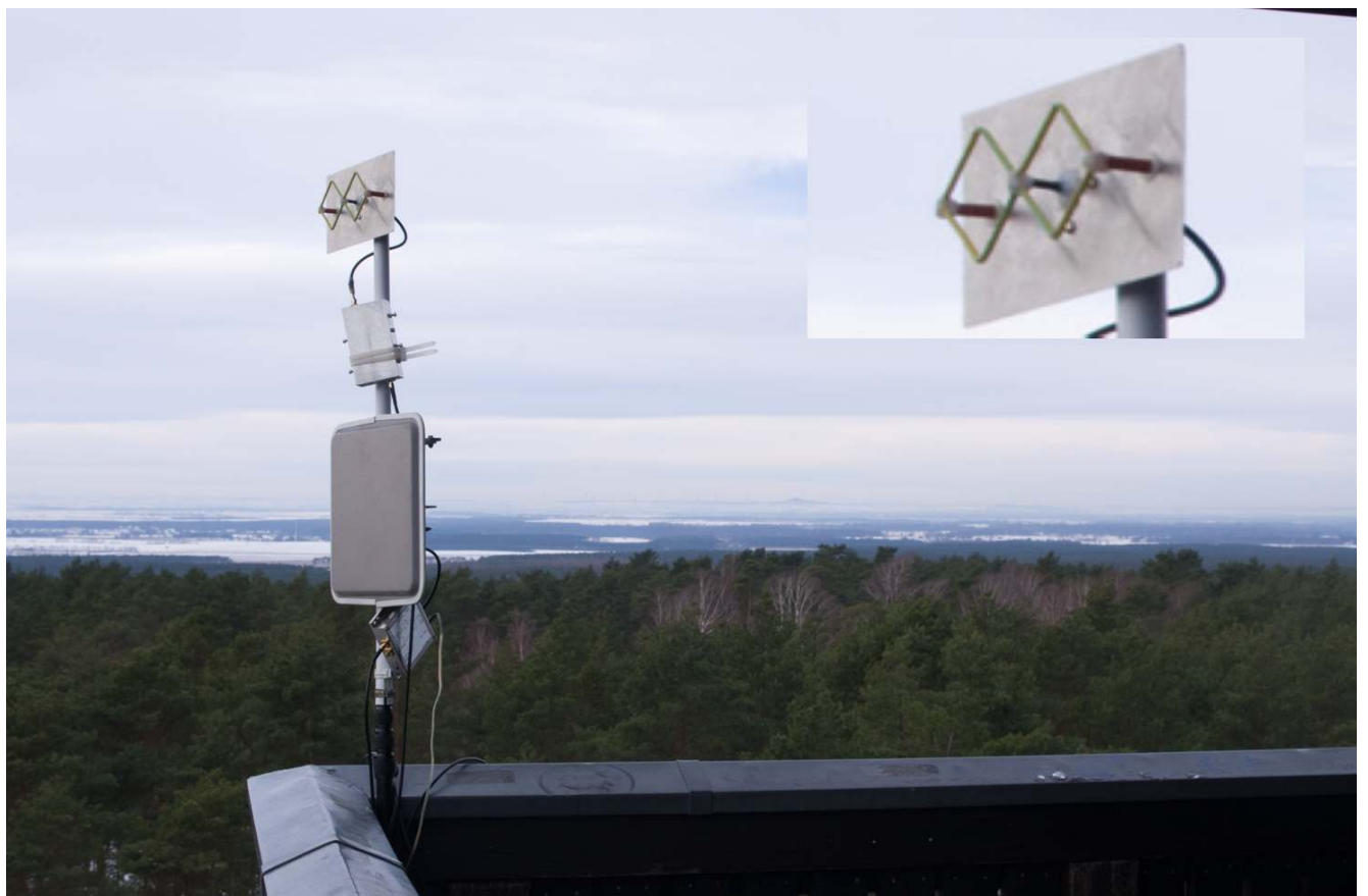
DL2XF's 23-cm-Doppelquad, Interdigitalfilter für 23 cm, 13-cm-Planarantenne und 13-cm-PA auf dem Heidebergturm, am Horizont der Collmberg
