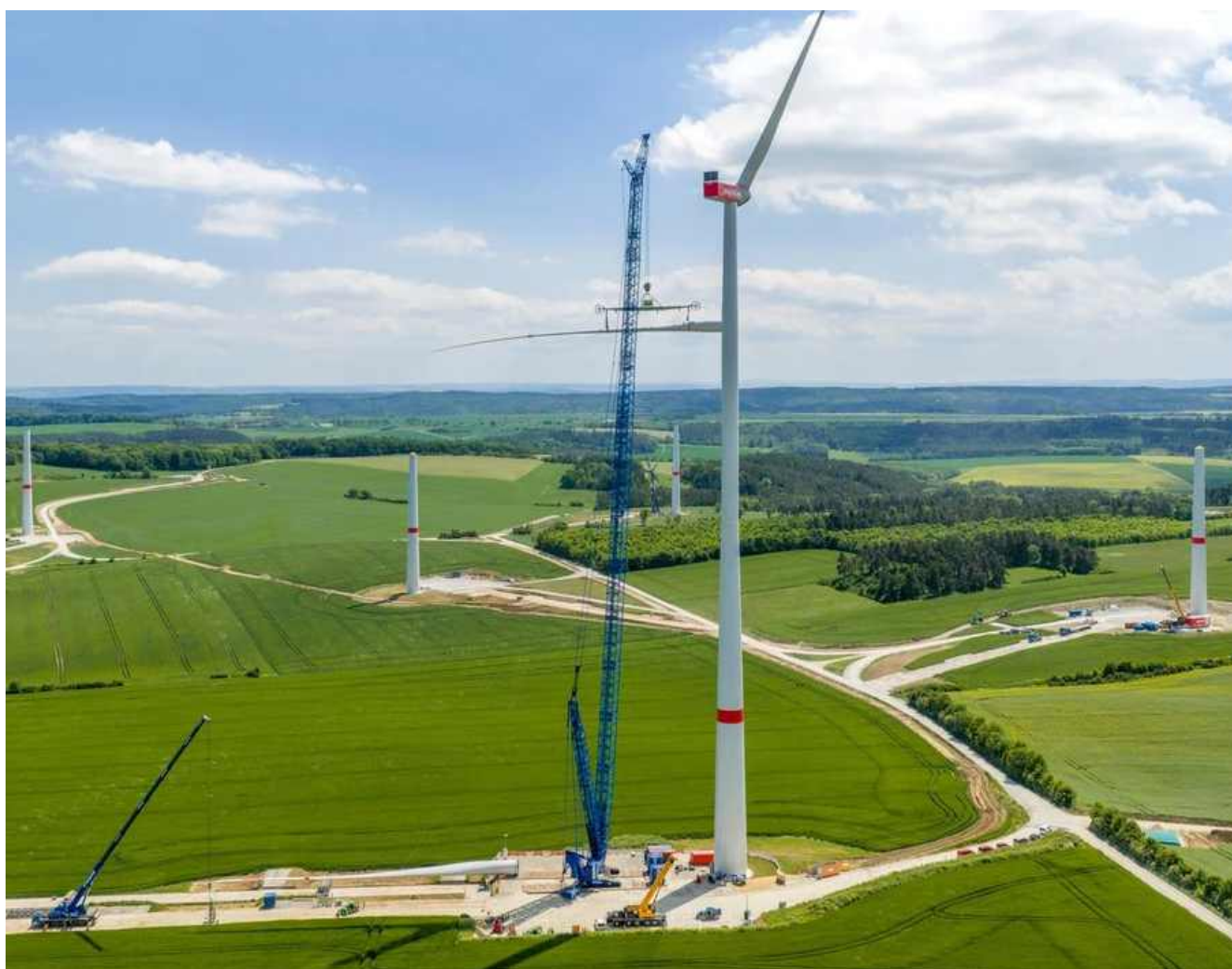
Blick von Manfreds (DL1ATI) Standort Holzberg in JO50QU auf die Baustelle der neuen 260m hohen Windmühlen
